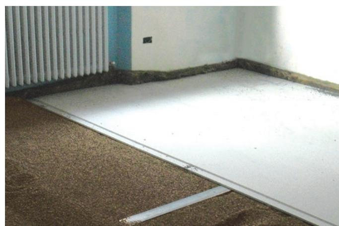
Poser les plaques/panneaux l'un après l'autre directement sur la couche d'argile expansée, en commençant par l'accès de la pièce. (bois-aggloméré, OSB, plaques de plâtre, avec ou sans isolant acoustique supplémentaire intégré ...) Opérer selon les indications des fabricants des panneaux.
